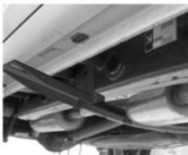
Рис.6 Установка среднего кронштейна
