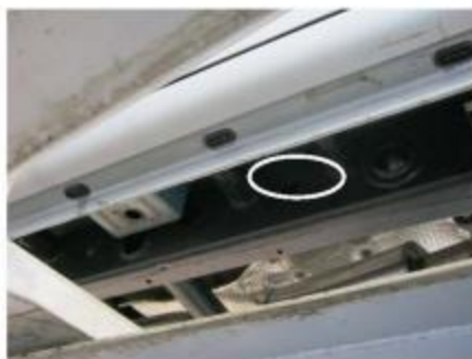
Рис.3 Установка шпильки закладной для среднего кронштейна
