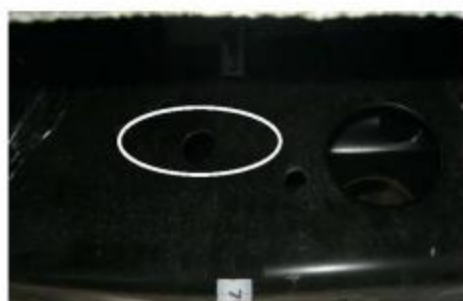
Рис.4 Установка шпильки закладной для крепления заднего кронштейна
